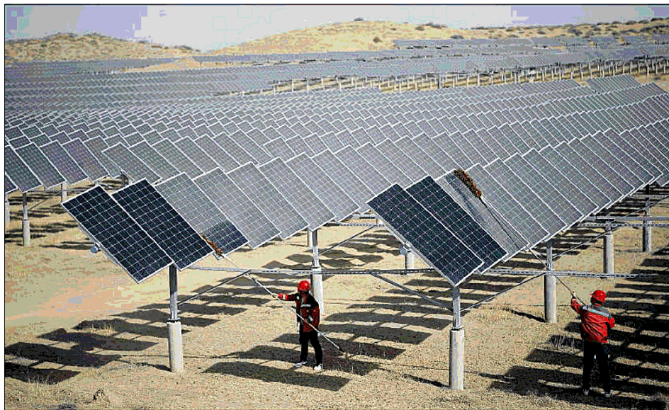
Operazioni di pulizia di pannelli fotovoltaici a Yinchuan, Cina (Ansa)
